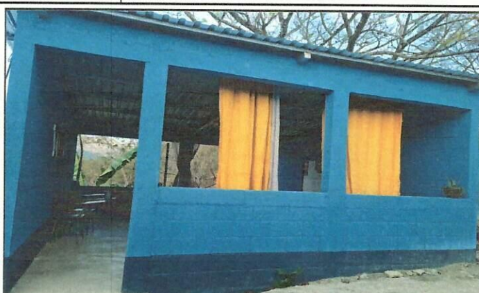
Foto 2: Cambio de vidrio en ventanales de aulas y cocina, e instalación de ventanas.
