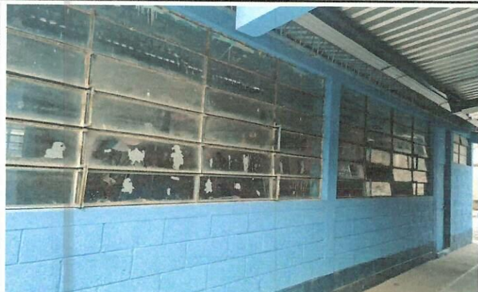
Foto 1: Cambio de vidrio en ventanales de aulas y cocina, e instalación de ventanas.
